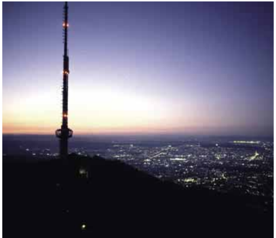
Die Stadt Zürich wird vom nahen Üetliberg aus versorgt. Da die meisten Rundfunksender auf Bergen oder Hügeln stehen, sind bewohnte Gebiete kaum je von starker Strahlung betroffen.
